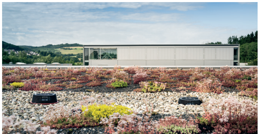
Sanierungs-Dachabläufe 63 T – zeitsparende Flachdachsanierung ohne Ausbau des alten Dachablaufs
